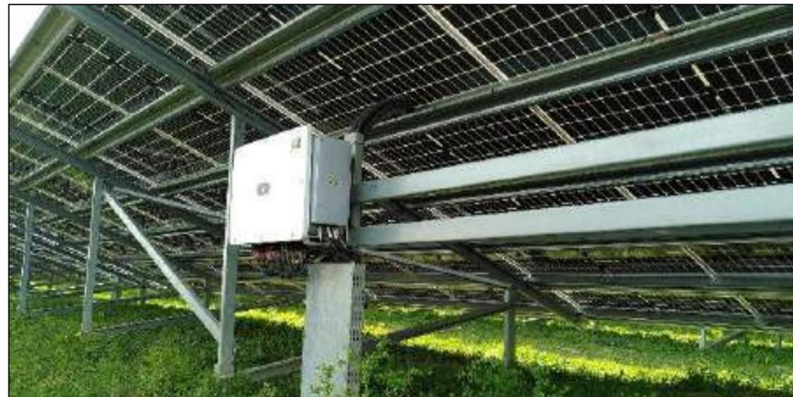
Figure 38 : Exemple d'onduleur accroché derrière les tables de modules (Source : TSE)
