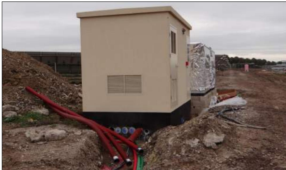
Photo 76 : Installation et raccordement d'un poste de transformation (Source : BE Jacquiel et Chatillon)
