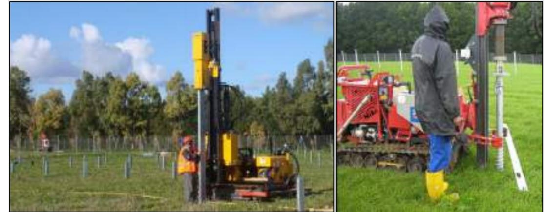
Figure 35 : Sonnette de battage hydraulique (gauche) et machine hydraulique de vissage (droite) (Source : TSE)
