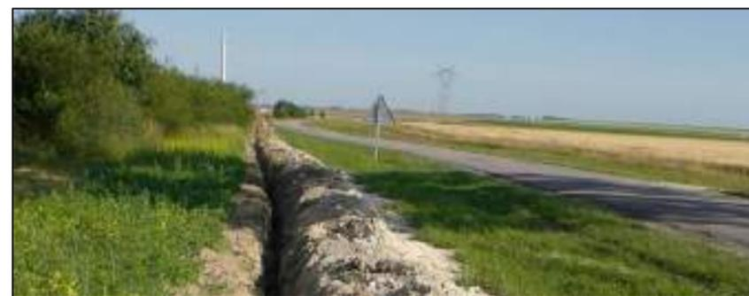
Photo 101 : Réalisation d'une tranchée pour le passage des câbles électriques
