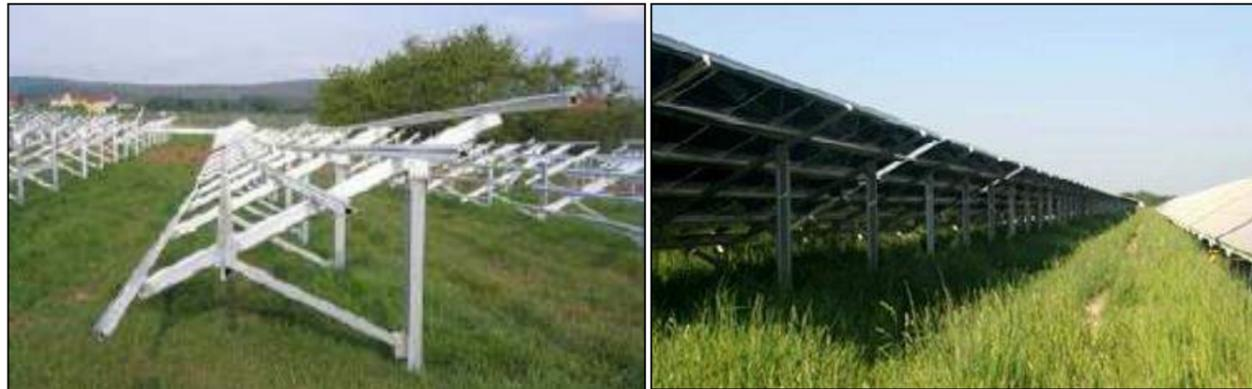
Photo 73 : Structures métalliques avant et après installation des modules photovoltaïques (Source : BE Jacquel et Chatillon)
