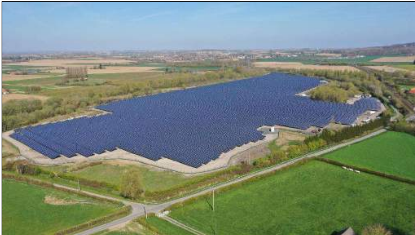
Figure 7 : Centrale au sol d'Oxlaère (59) mise en service en 2021 : 18.4 MWc (Source : TSE)
