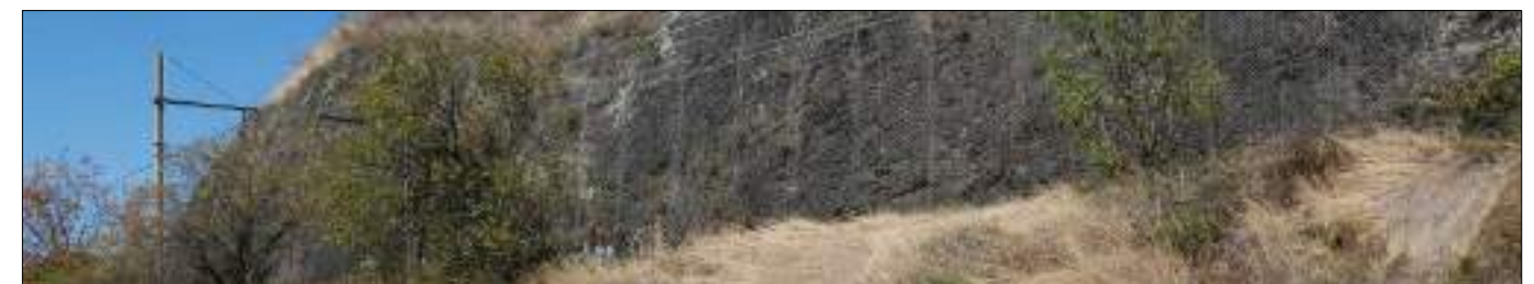
Photo 40 : Passage de la ligne ferroviaire en bas du relief à la sortie de Vienne en direction du projet (Source : BE Jacquel et Chatillon)
