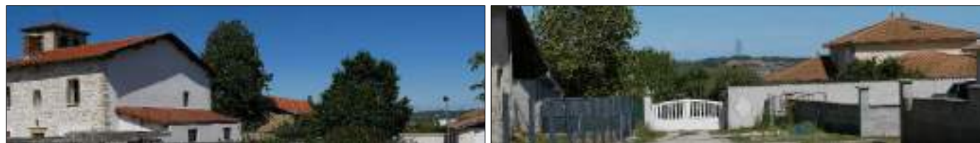
Photos 23 (LV2) : Vues au sein du quartier ancien de l'Eglise (Source : BE Jacquel et Chatillon)
