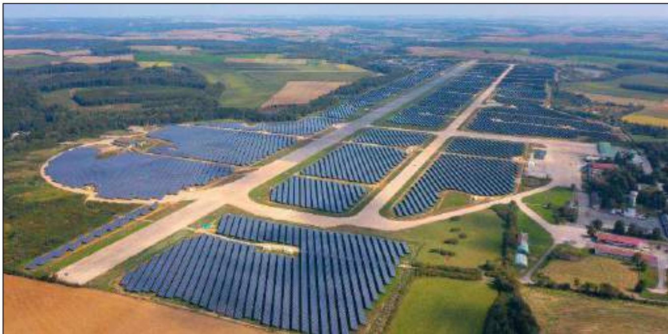
Figure 8 : Centrale au sol de Marville (55) mise en service en 2021 : 155 MWc (Source : TSE)
