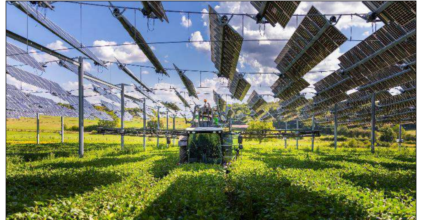
Figure 9 Projet pilote de canopée agricole d'Amance (70) mise en service en 2022 : 2.7 MWc (Source : TSE)
