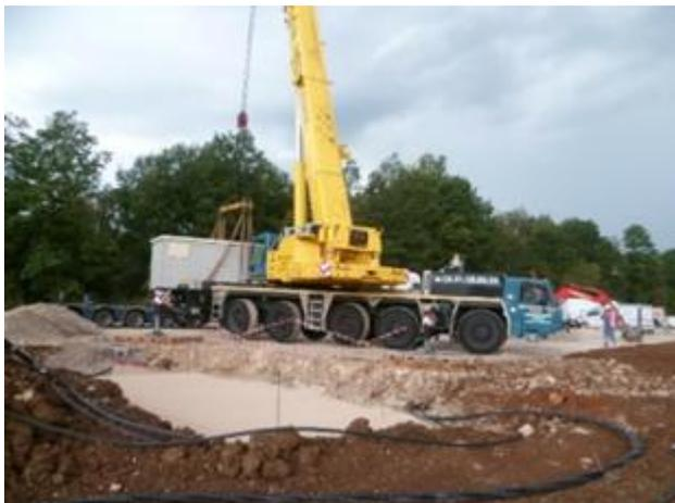
Figure 4-9: Installation d'un poste de livraison
