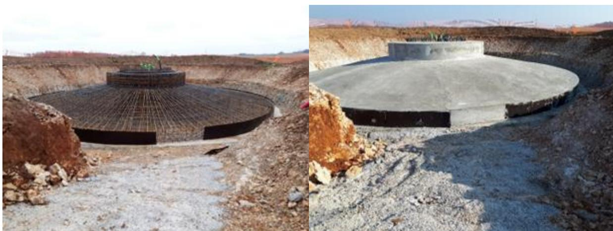
Figure 4-4: Avant (gauche) et après (droite) coulage du béton dans la fondation
