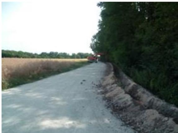
*Figure 4-6: Enfouissement du réseau électrique le long d'un accès (source : CNR)*
