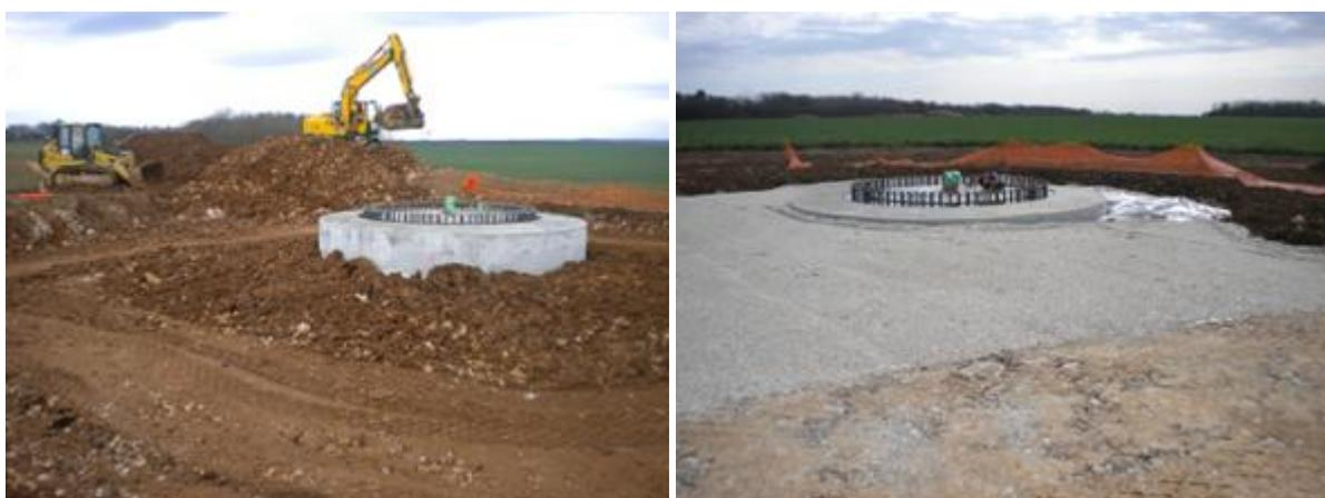
Figure 4-5: remblaiement des terres sur la fondation de la future éolienne (source : CNR)
