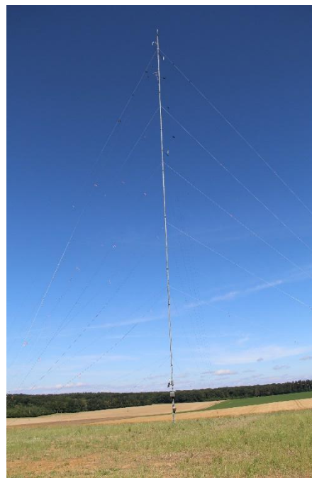
Mât installé sur la ZIP
