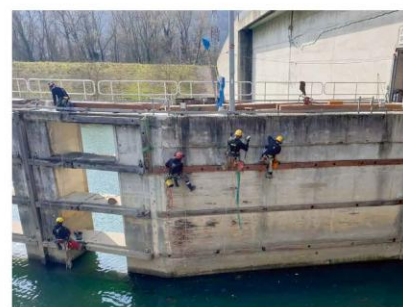
Maintenance durant l'arrêt de navigation
