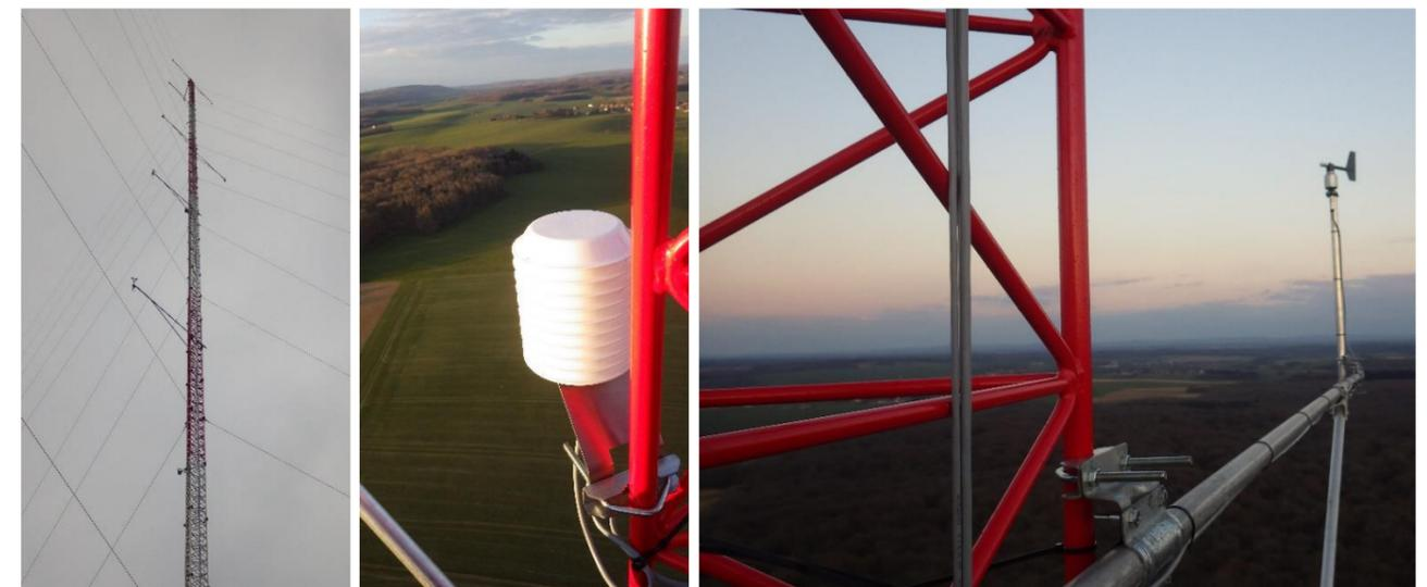
**Photographie 2 – Mât de mesure, anémomètres et girouettes (Source : ABO Energy, mars 2016)**
