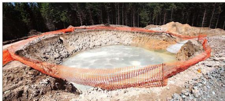
Béton de propreté sur le fond de forme
