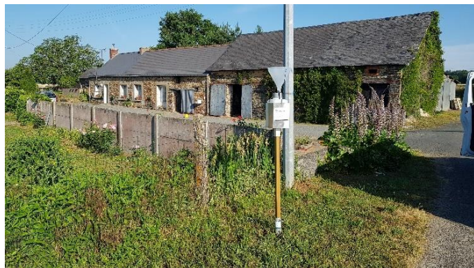
FIGURE 4.4 : Emplacement 2 – Habitation Est
