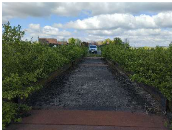
Vue du pont bascule vers l'entrée du site
