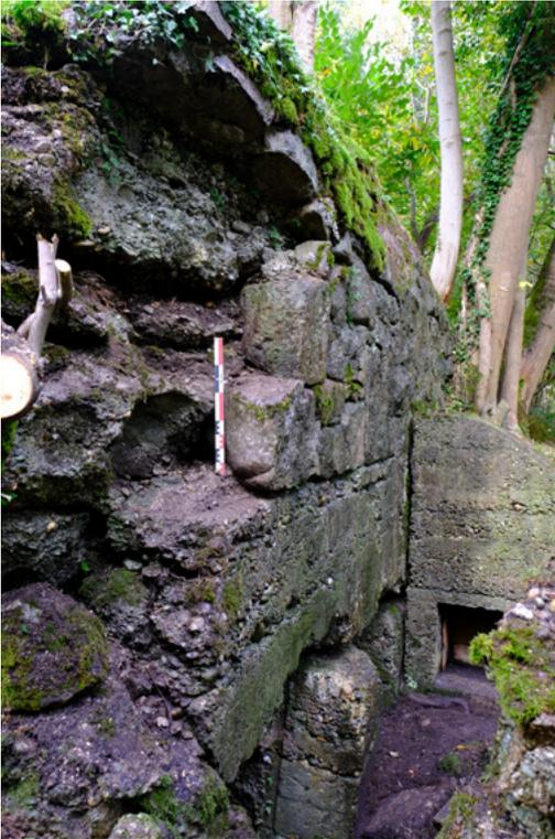
Fig. 44. Vue du parement extérieur constitué de gros blocs de pierre
