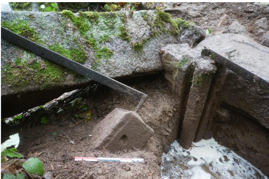
Fig. 24. Vue du blocage de mortier de chaux reliant le bloc de granite et le piédroit
