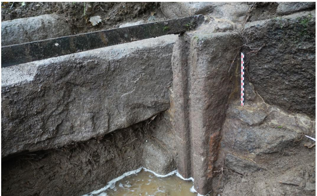
Fig. 22. Vue du piédroit en deux parties et les blocs de pierre liés à la chaux
