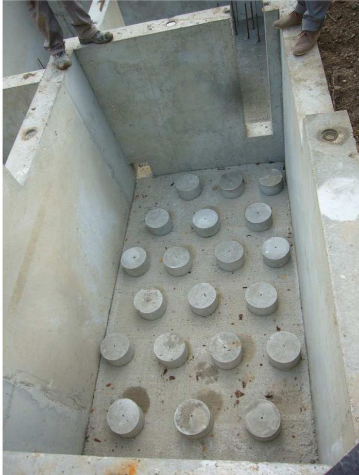
*Disposition de la rugosité de fond (source : Jileo)*
