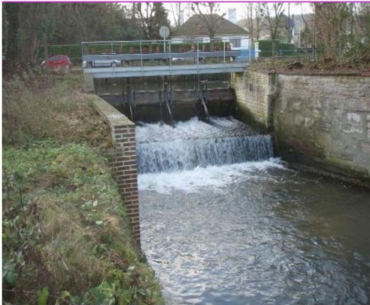
**Figure 10: Exemple de vanne de décharge**
