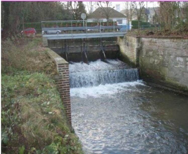
**Figure 10: Exemple de vanne de décharge**
