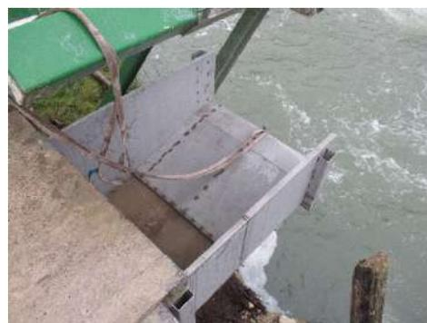
Le poisson sera restitué une dizaine de mètres en aval du barrage. Le fond au droit de la restitution du débit de dévalaison sera établi au minimum 1.0 m sous le niveau d'eau en période d'étiage, soit un tirant d'eau suffisant pour la réception sans dommage du poisson. La fosse devra présenter une surface d'au moins  $2 \text{ m}^2$ .
