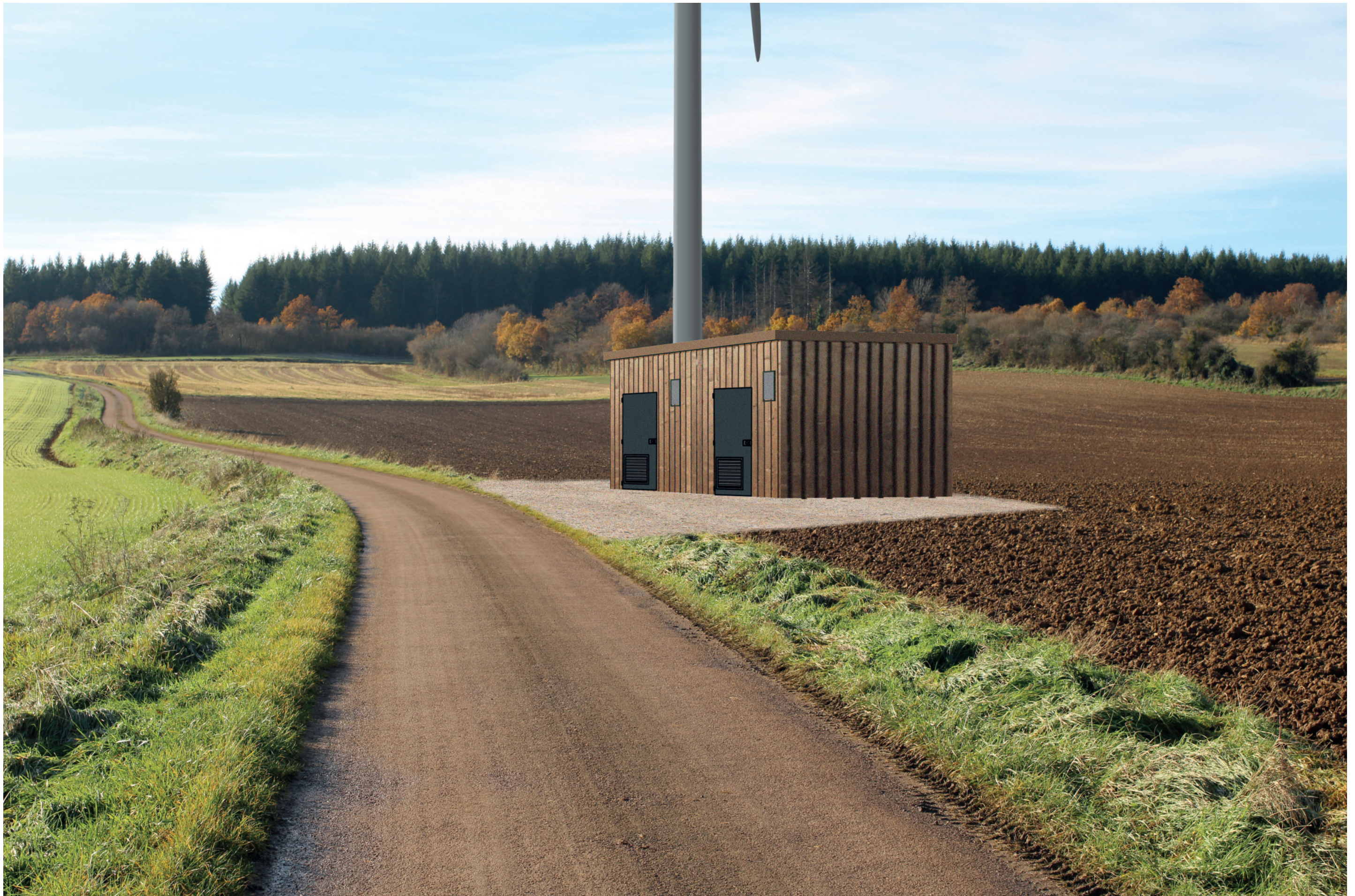
Figure n° 8 : Poste de livraison
