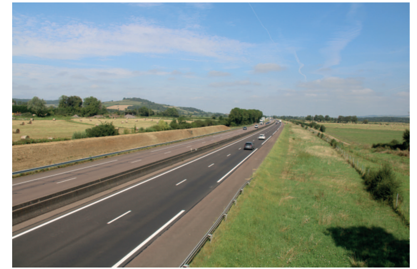
Photo n° 98 : Les grandes infrastructures qui coupent le paysage
