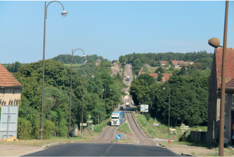
Photo n° 89 : La route départementale 70 rectiligne
