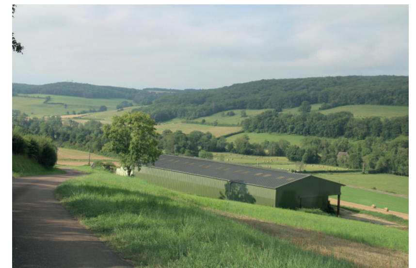
Photo n° 99 : Les bâtiments agricoles
