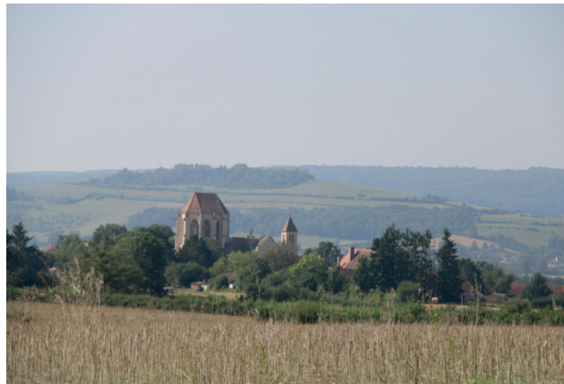
Photo n° 50 : Covisibilité possible entre l'église de Saint-Thibault (15) et le projet éolien
