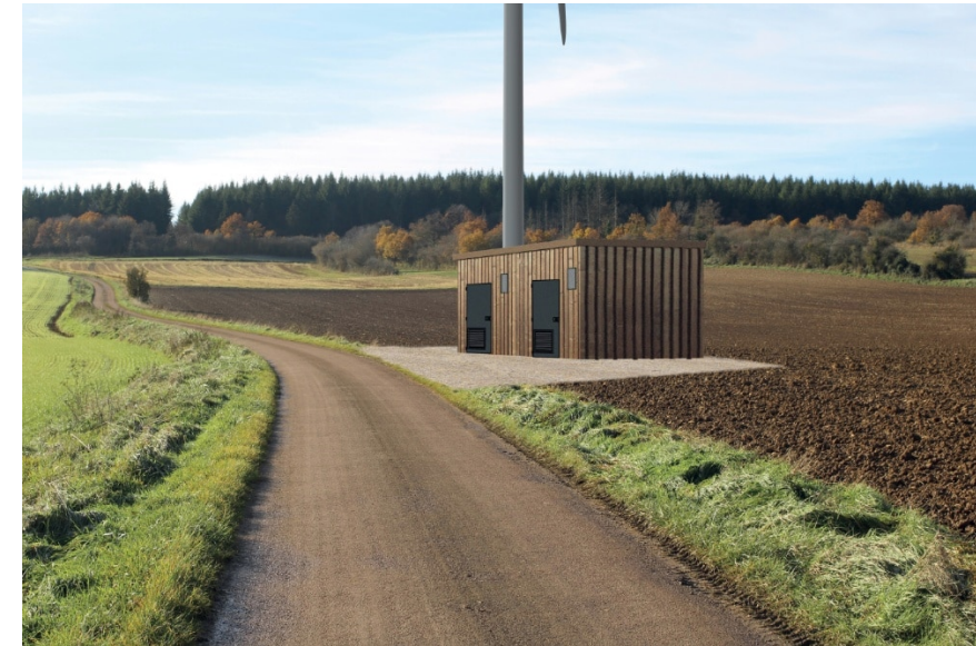
Habillage du poste de livraison
