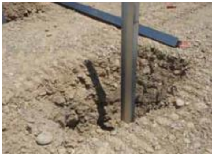
Figure 9 : Exemple de pieux en acier (Source : Guide de l'étude d'impact 2011)
