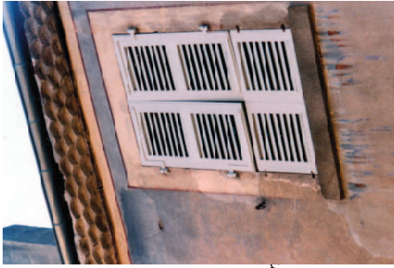
Badigeon sur enduit, avec détournement des ouvertures. La façade est plus vivante et présente une unité dans sa diversité.
