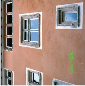
Badigeon sur enduit, avec détournement des ouvertures. La façade est plus vivante et présente une unité dans sa diversité.
