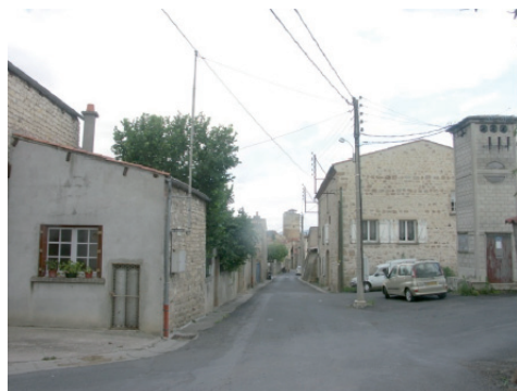
La rue de la Garenne AVANT travaux
