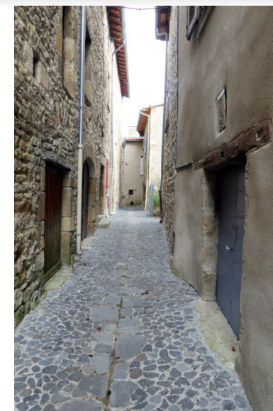
calade d'une ruelle du fort récemment restaurée
