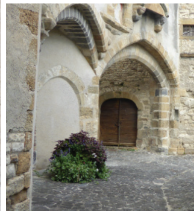
Les ruelles principales d'accès au fort sont recouvertes d'un dallage basaltique en «opus incertum».
