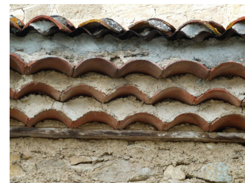
une génoise traditionnelle : des rangs alternés de tuiles canal
