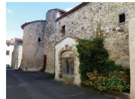
Angle nord-est du rempart - parcelle 484
