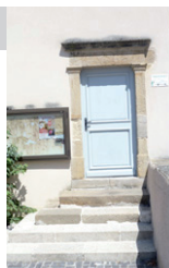
Petit bâtiment communal
