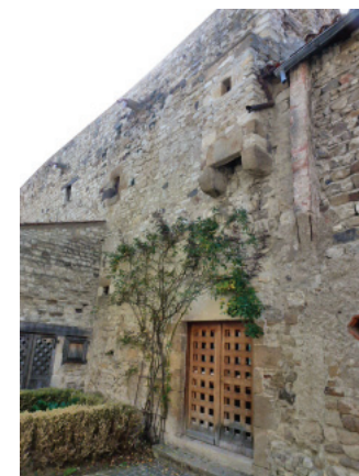
Latrine - rue des Remparts parcelle 491
