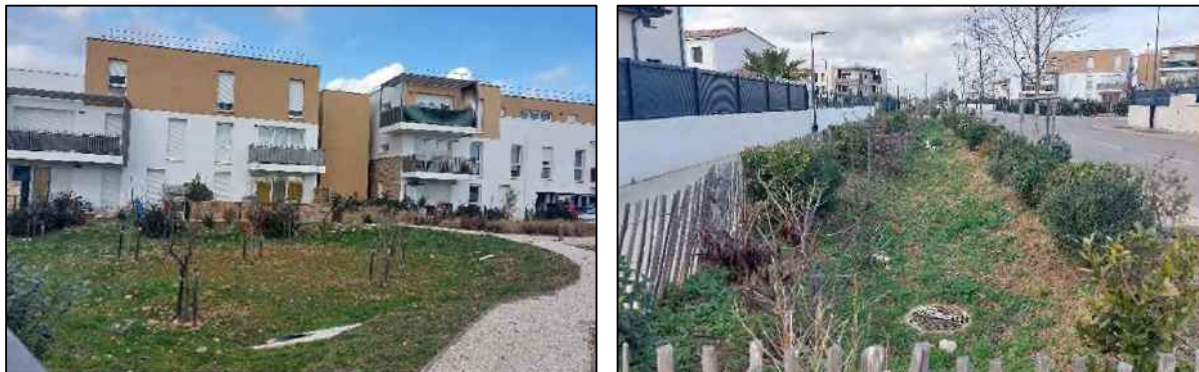
Figure 30 : Exemple de système gestion intégrée de la ZAC des Amoureux : Bassin de compensation (à gauche) et noue de collecte (à droite)
