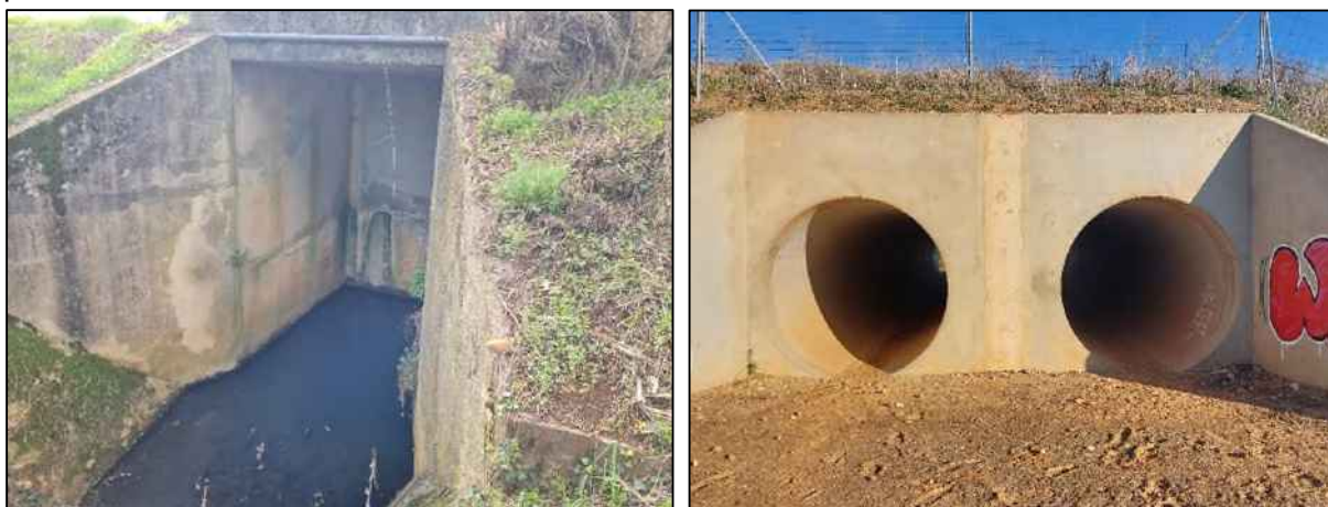
Figure 23 : Exemple d'ouvrage de traversée : Siphon sous le canal des Costières (à gauche) et traversée sous la voie de chemin de fer (à droite)
