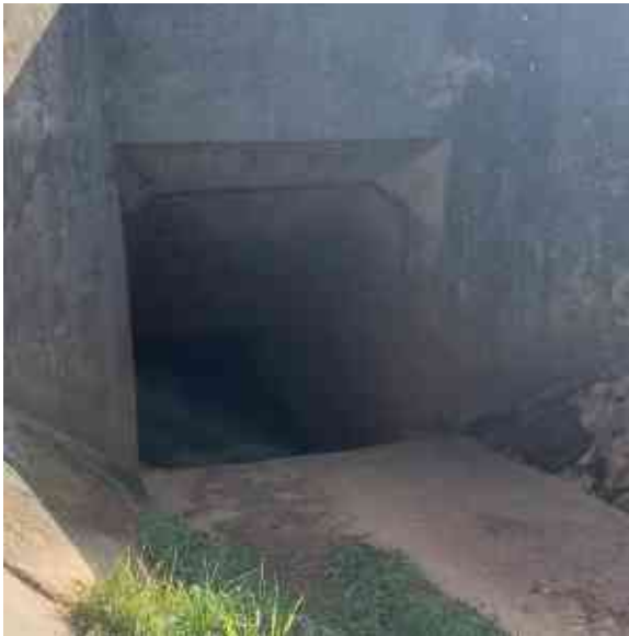
Figure 8 : Passage en syphon sous le canal des Costières
