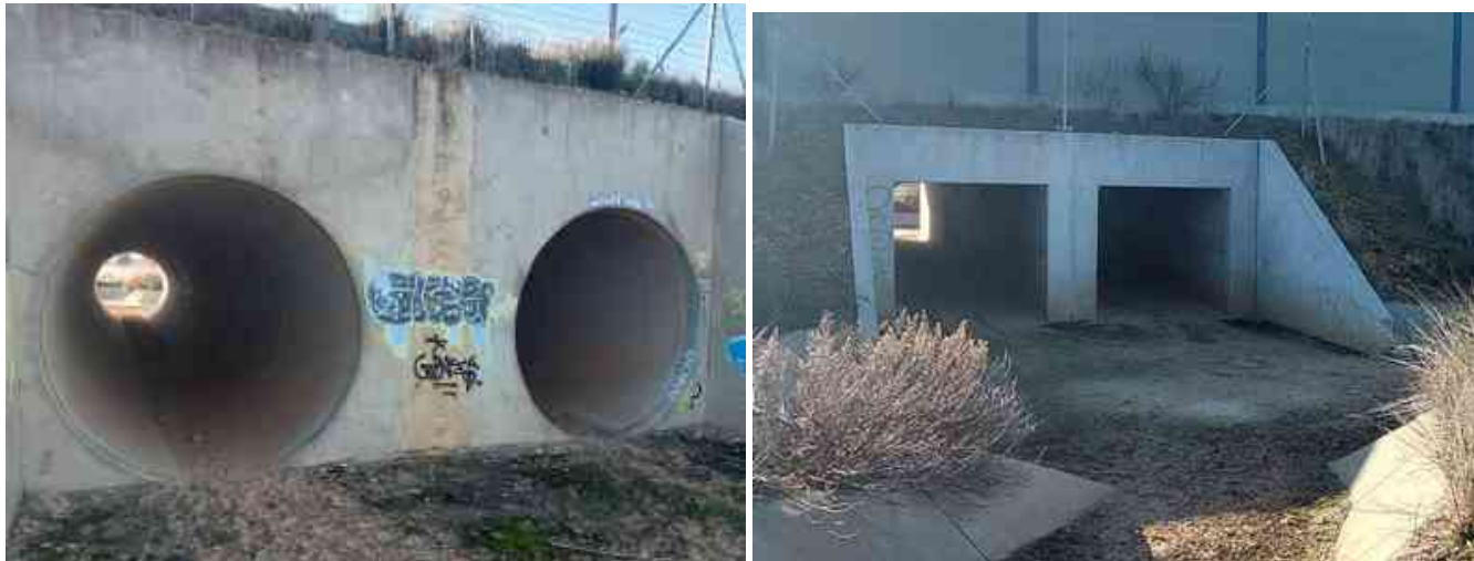
Figure 4 : Aménagement permettant le passage sous la voie de chemin de fer (2 D2200 mm à gauche et 2 cadres 2 m de large par 1.5 m de haut
