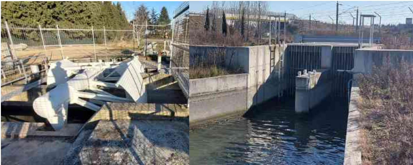
Figure 5 : Ecluse du canal (à gauche) et passage sous la voie ferrée du canal (à droite)
