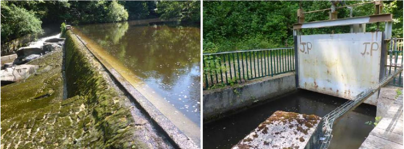
Photos du seuil vu de la rive gauche et de la vanne de garde du canal en rive gauche
