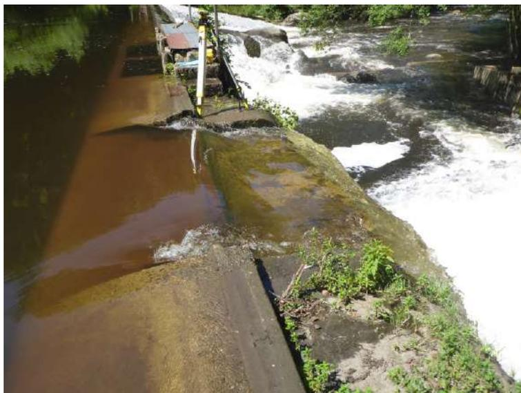
Photographies de la passe à poissons, de son pré-barrage et de l'échancrure pour le débit d'attrait
