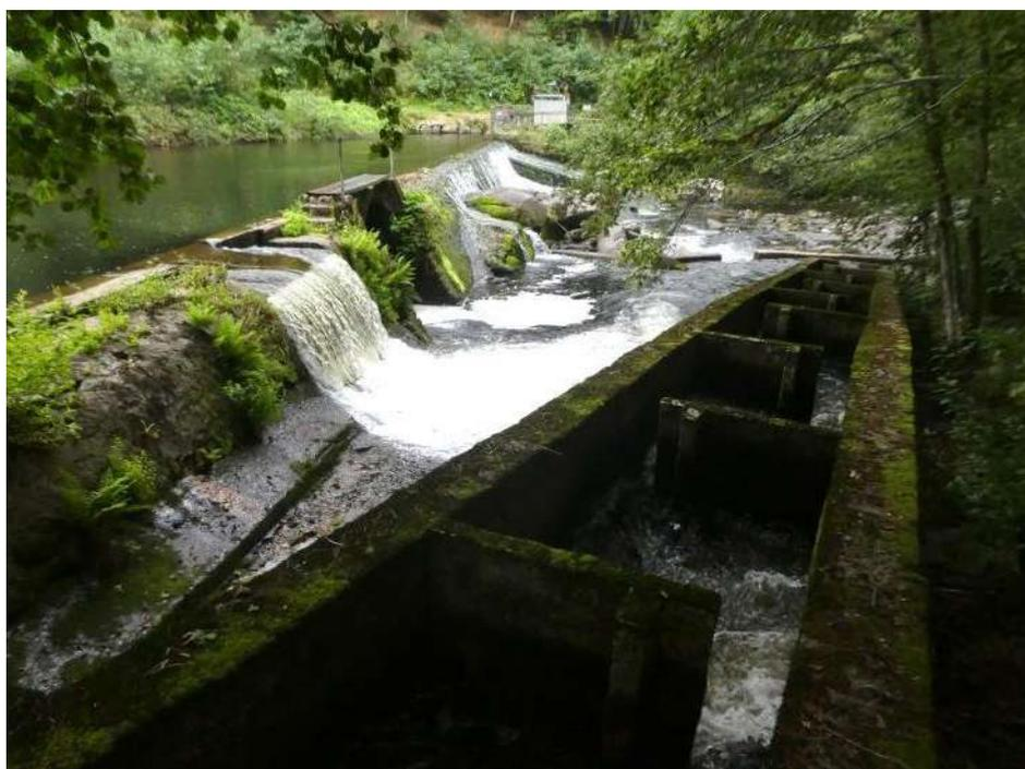
**Figure 19 : vue sur l'aval du barrage de Charnaillat : canal de dérivation et passe à poisson actuelle**
