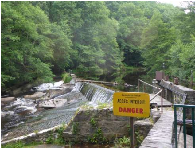
Seuil de prise d'eau - HYDRO-M juin 2020
