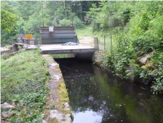
Amont du canal d'amenée - HYDRO-M juin 2020
