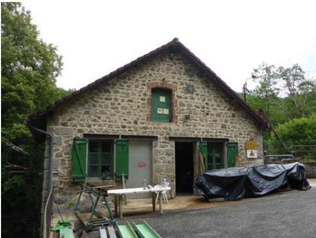
Bâtiment usine - HYDRO-M juin 2020
