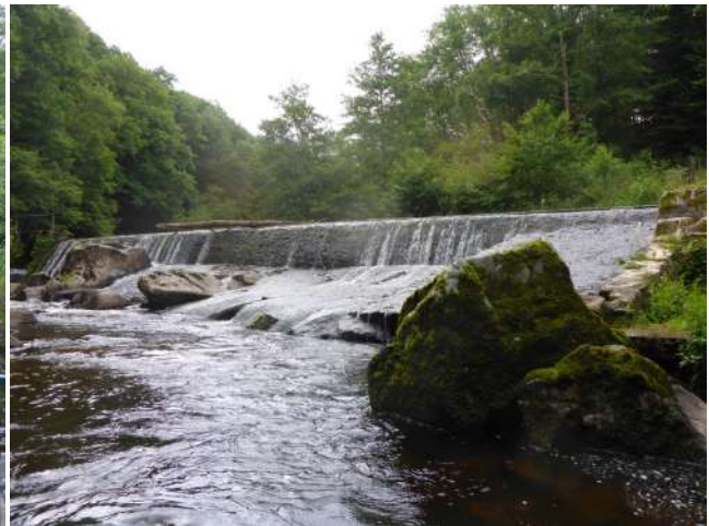
Seuil de prise d'eau, vue de l'aval - HYDRO-M juin 2020
