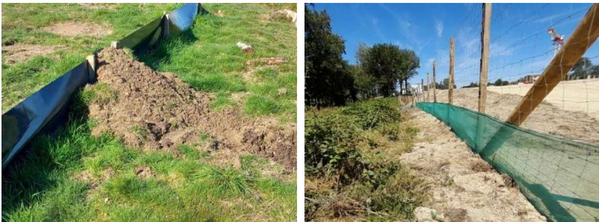
Figure 1 : Exemples de filets de protection pour limiter l'accès de la petite faune à un chantier (ENCIS Environnement)
