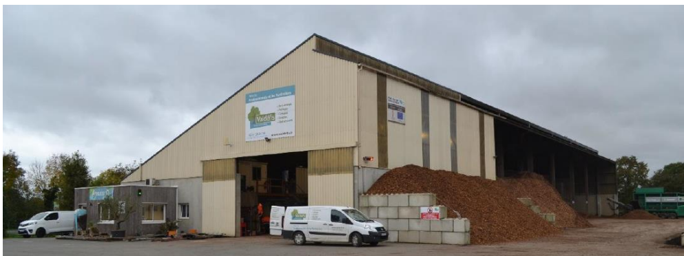
Illustration 22 : Bâtiment du site (photo site 10/2024)
