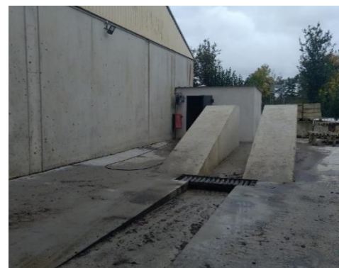
Illustration 19 : Piste de lavage (photo site 10/2024)
