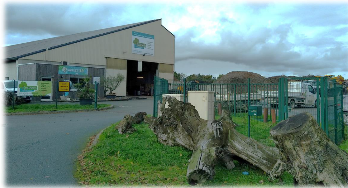
Plateforme de Valorisation de biomasse au Poiré-sur-Vie (85) portée par la société VALDEFIS
