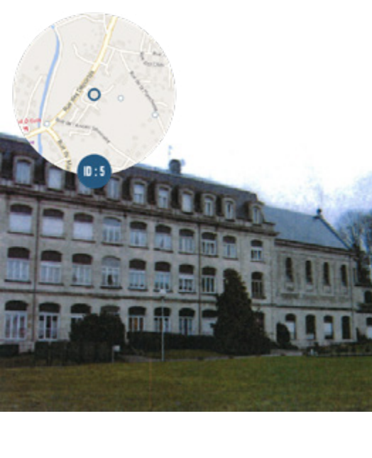
8 RUE DES DÉPORTÉS - 88445 - SAULCY-SUR-MEURTHE
