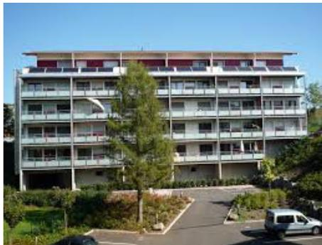
La résidence les Héliades, il s'agit d'une construction de deux bâtiments collectifs à ossature bois et énergie positive regroupant 30 logements sur la commune de Saint-Dié-des-Vosges. La conception architecturale bioclimatique, caractérisée par une compacité très forte des deux bâtiments, une bonne valorisation des apports solaires passifs et une implantation environnementale optimisée assure aux locataires un très haut niveau de confort ainsi que des charges de chauffage très limitées.
