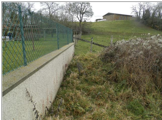
**Figure n°15: Surélévation de terre qui détourne les écoulements (à gauche). Un « trou » en bordure du mur de la propriété adjacente permet à l'eau de s'écouler (à droite)**
