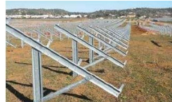
Photo 22 : Pieux battus (H2air)
