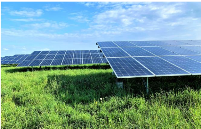
Photo 24 : Installation terminée (H2air)
