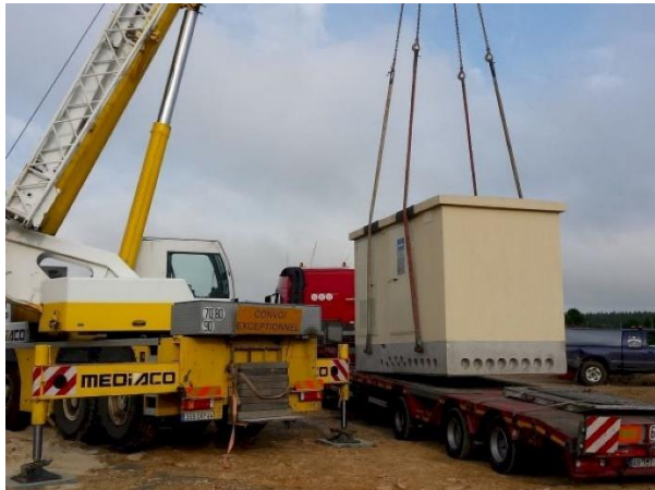
Photo 23 : Déchargement d'un poste de livraison (H2air)
