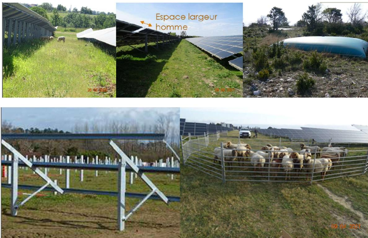
**Photo 4 : Exemple d'aménagement pour la prise en compte de l'atelier ovin dans la conception de la centrale**
