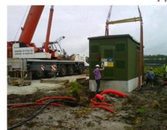
Photo 5 : Déchargement d'un PDL
