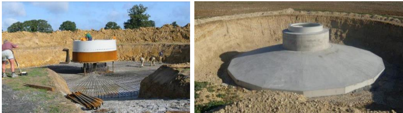
Ferraillage et le coulage d'une fondation d'éolienne
