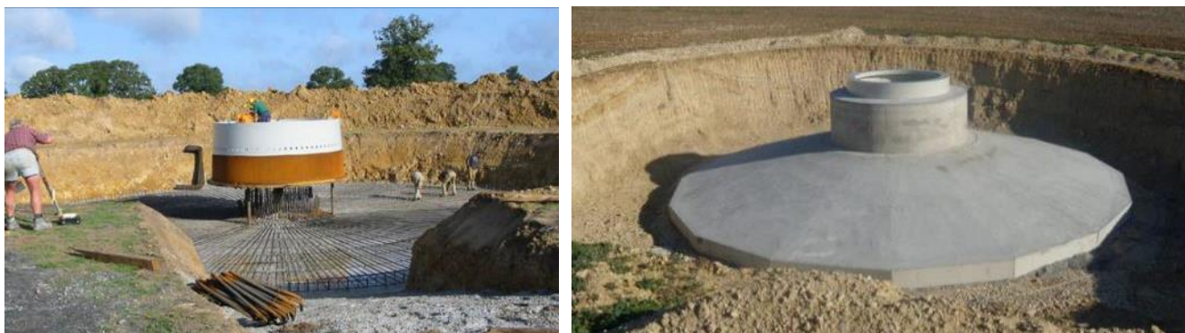
Le ferraillage et le coulage d'une fondation d'éolienne
