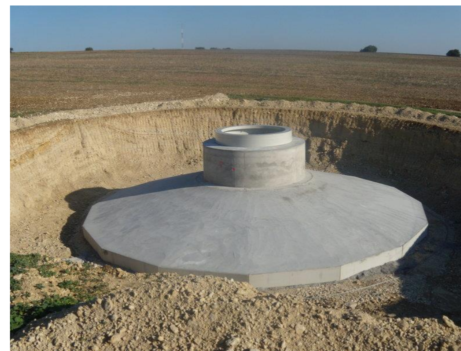
Photo 2 : Le ferrailage et le coulage d'une fondation d'éolienne
