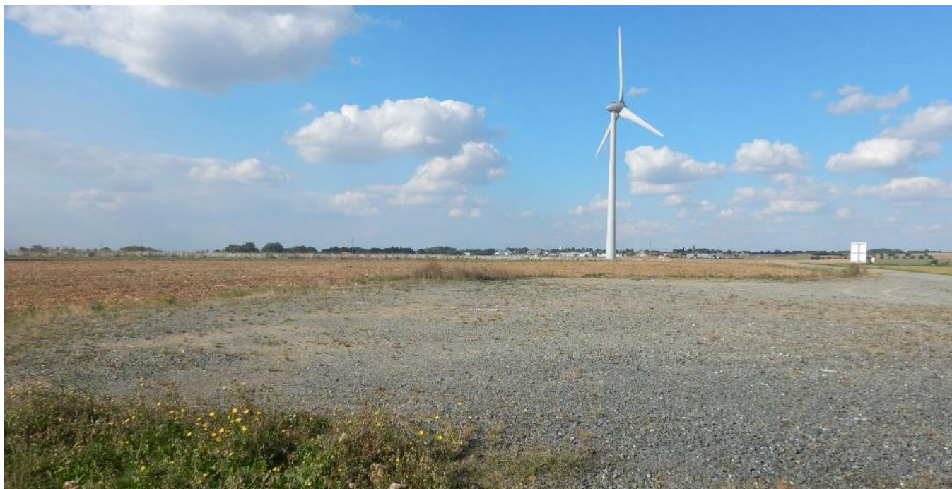
Photo 3 : un exemple d'aire de grutage depuis le pied d'une éolienne
