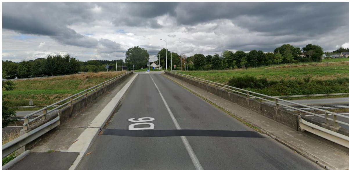
Photo 23 : franchissement supérieur de la RN 164 depuis les secteurs n°8 (vue vers le nord)
