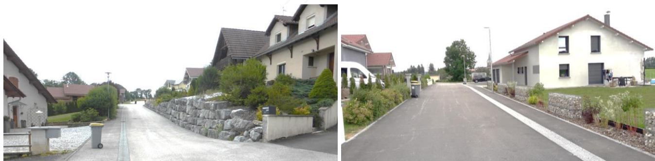
Exemples de clôtures et mur de soutènement le long du Clos Lessus et rue du Chasseral
