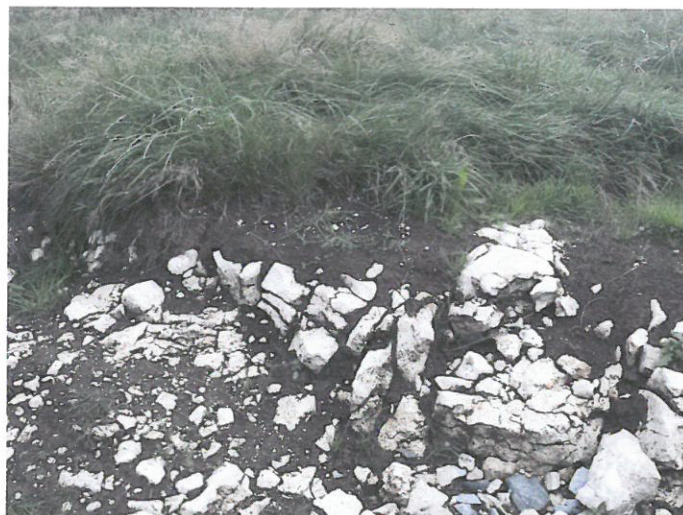
Vue en coupe des sols assez superficiels du secteur
