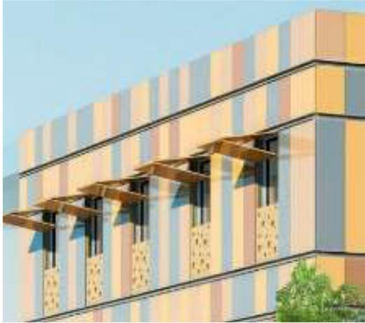
Le contrôle des apports solaires pour le confort des usagers est un enjeu important dans le cadre du projet. Ainsi, le projet propose des systèmes d'occultations des fenêtres verticales des bureaux et autres systèmes de protection solaires comme l'emploi d'auvents.
