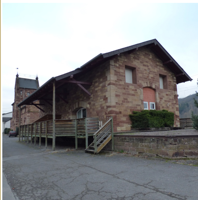
Bâtiment secondaire- Façade 9
