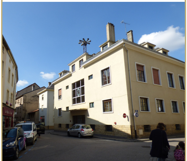
Mairie 12 Quai des Ducs de Lorraine vue depuis la Grand'rue
