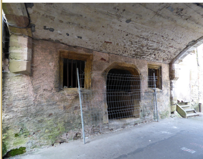
Façade 3 sous la voûte
