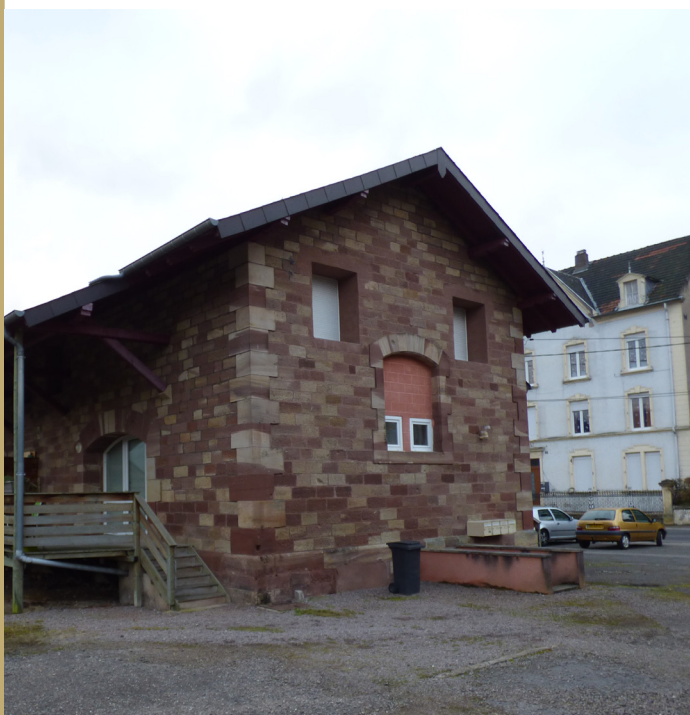
Bâtiment secondaire- Façade 8
