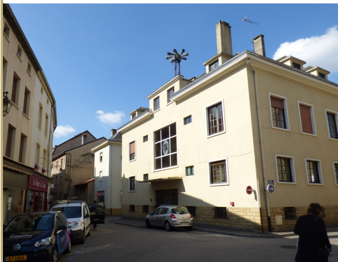
Bâtiment 1, façades 2 et 3 Grand'rue
