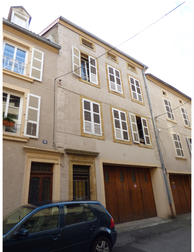
Façade 18 Rue de la Tour de l'Horloge
