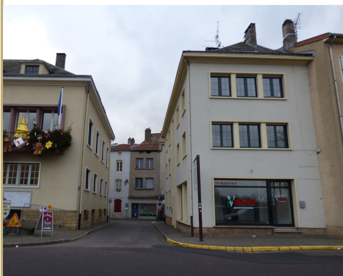
Bâtiment 2, façade 4 et bâtiment 1 façade 3
