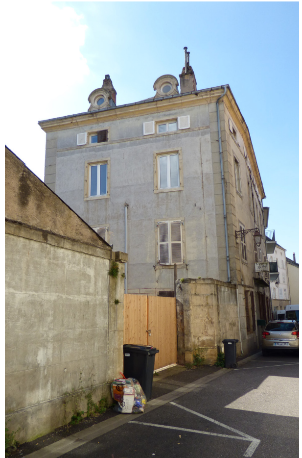
Façade 3 Rue Portes de Trèves
