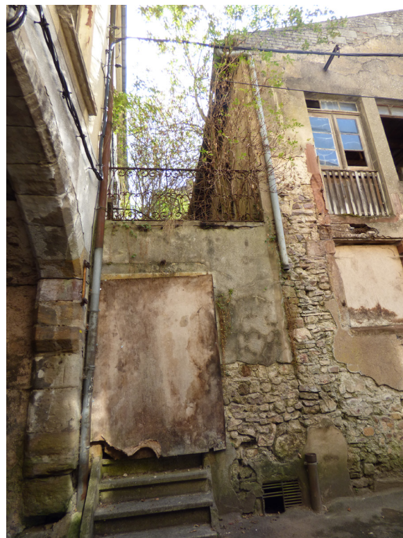
Façade 5, accès sur la Grand'rue
