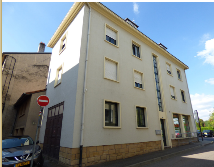
Bâtiment 2, façades 5 et 6 Grand'rue
