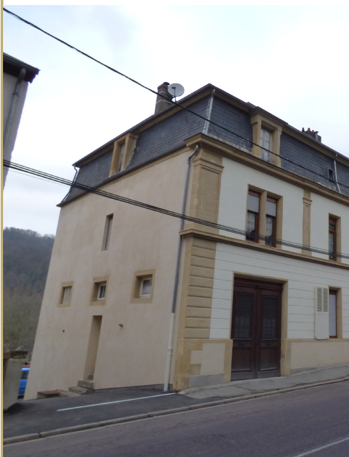
Façade secondaire latérale est 2
