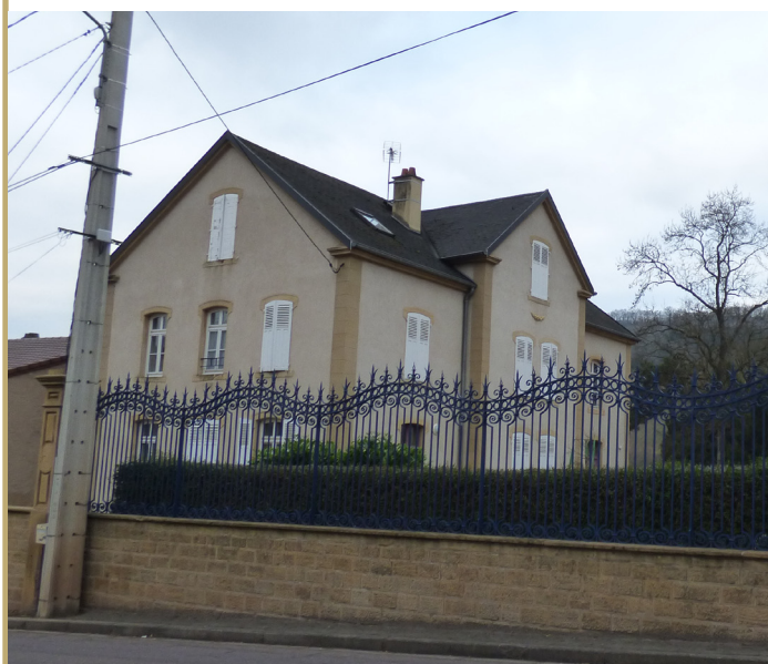
2. Façade principale bâtiment secondaire est
