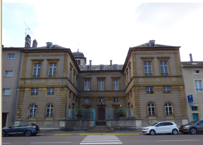
Façades 1, 2, 3 Quai des Ducs de Lorraine
