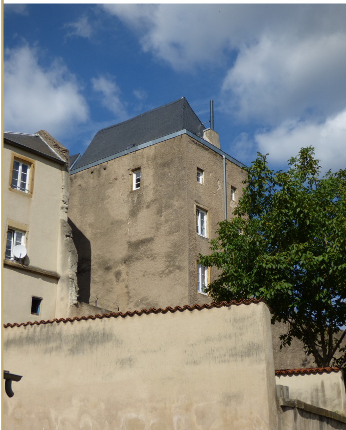
Façades remarquables 1 et 2, 7 Place Jeanne d'Arc
