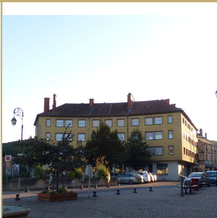
Edifice du Passage de l'Ancienne Synagogue vu depuis la Place Jules Florange
