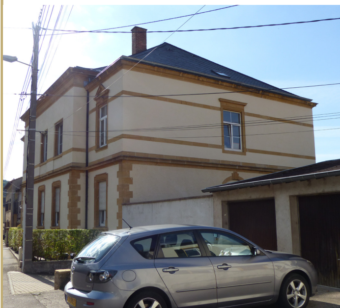
Façade secondaire latérale 2
