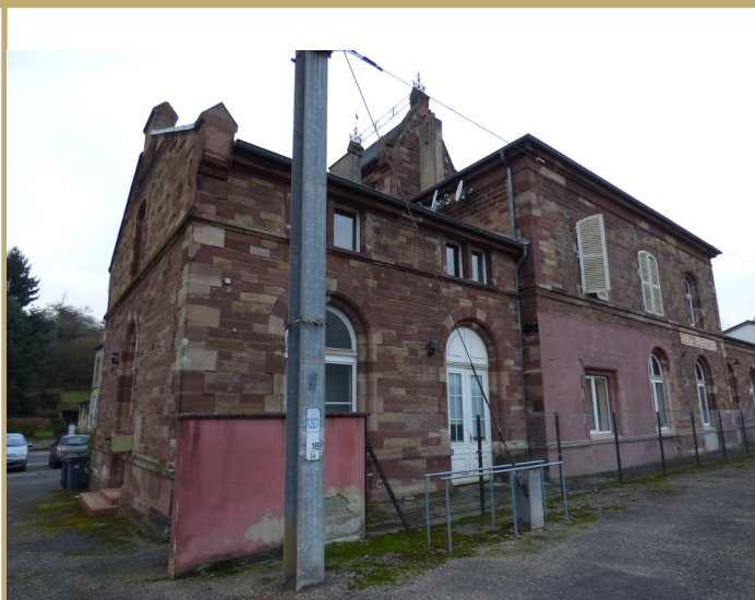
Bâtiment 1 principal- Façade 2
