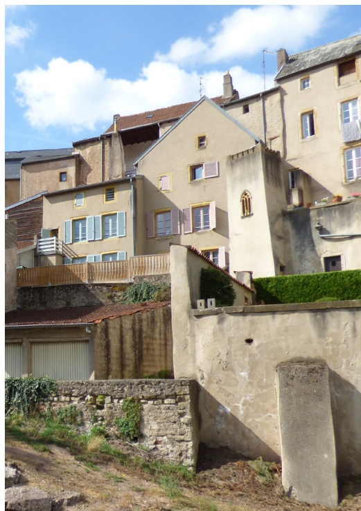
Façades remarquables 1 et 2, 4 Place Jeanne d'Arc
