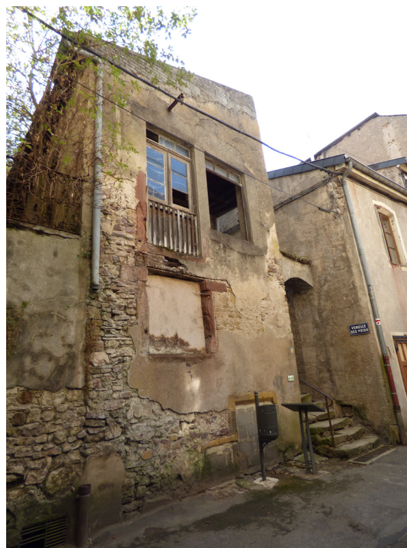
Façade 4 sur la Grand'rue du bâtiment en tête d'îlot
