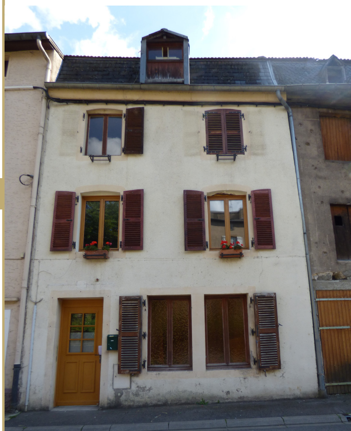
Façade, 17 Rue du Moulin
