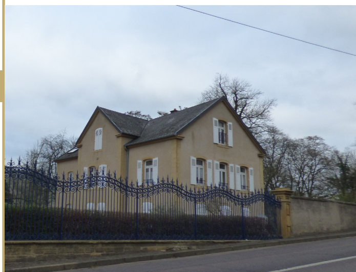
4. Façade principale bâtiment secondaire ouest
