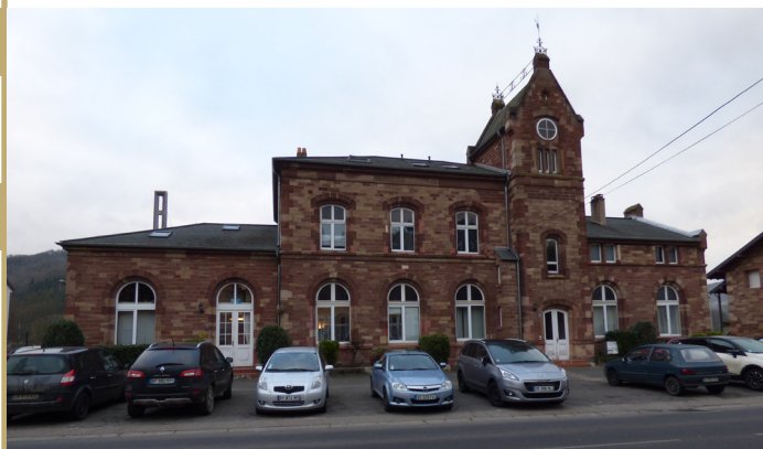
Bâtiment 1 principal- Façade 1
