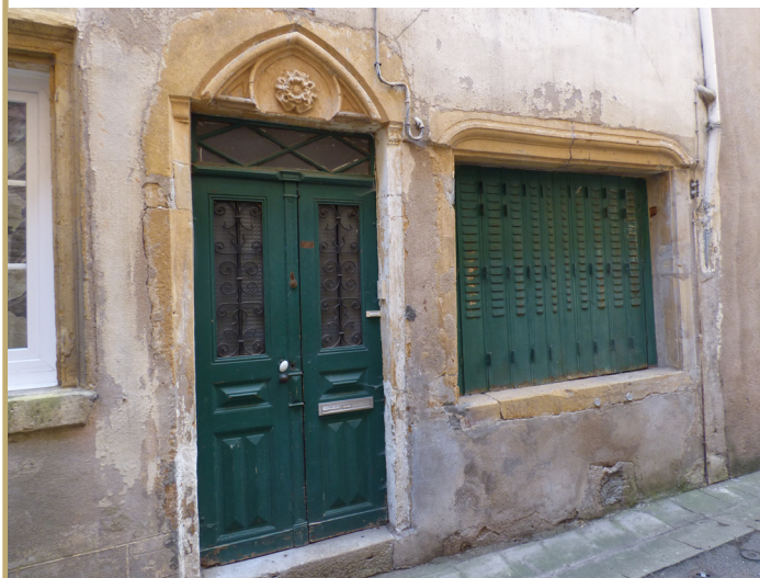
Détail porte et fenêtres façade 1
