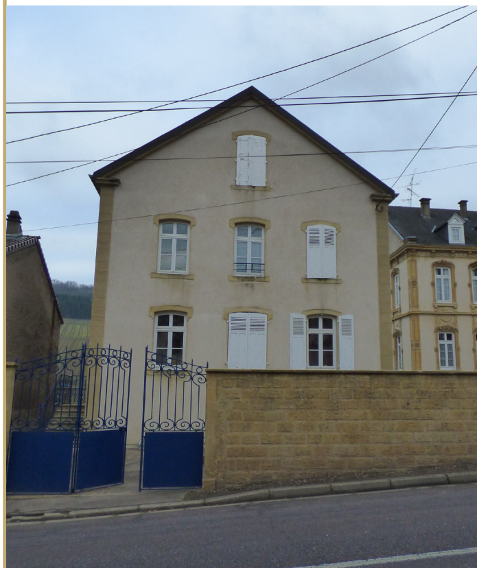
3. Façade secondaire bâtiment secondaire est
