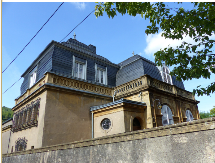
Vue depuis la rue du Docteur Fristo, façades 1 et 2
