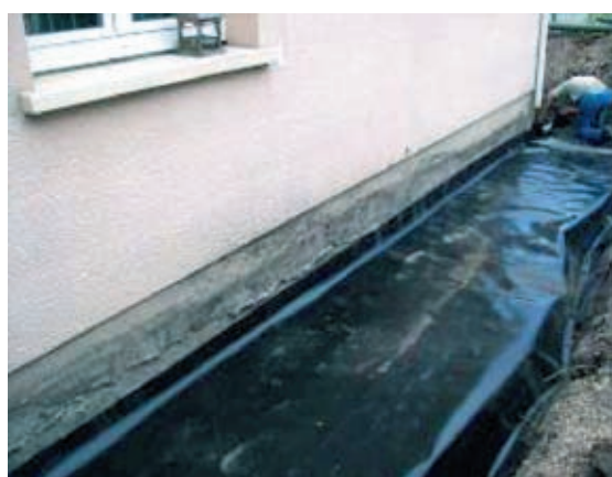
Figure 22 Géomembrane en cours de pose (Source Socabat)
