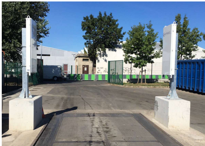
Portique de détection de la radioactivité GammaScan® eVolution4
