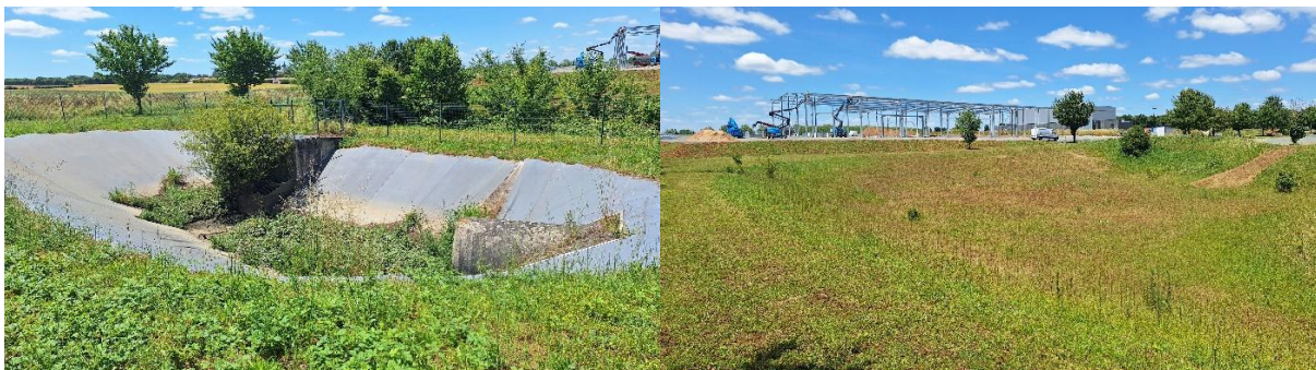
Figure 16 : Photo du bassin naturel d'infiltration pour les eaux pluviales
