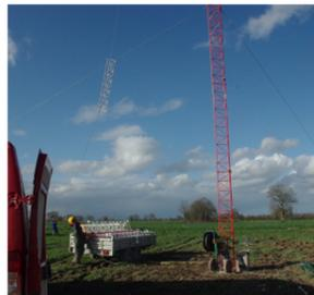
Le montage du mât est réalisé à l'aide d'une potence homologuée et d'un treuil de sécurité. Il n'est pas nécessaire de faire appel à une grue. L'équipe est composée de 4 personnes (deux grimpeurs et deux personnes au sol).
