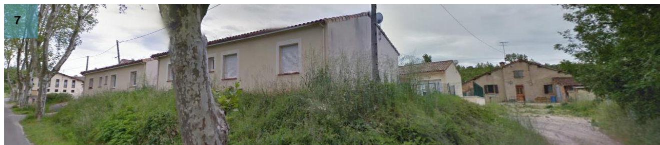
Photos 8 : Bâti proche de la zone d'implantation potentielle (source : Google Street View)
