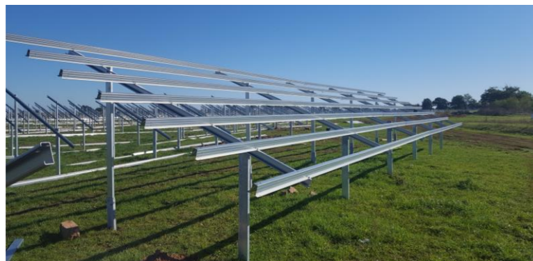
Photo 19 : Mise en place des structures sur pieux battus, parc JPEE de Braize (03) (source : JPEE)
