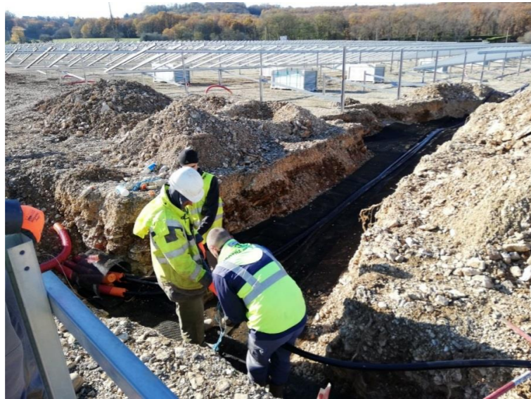
Photo 27 : Mise en œuvre des nappes basses tension sur le parc JPEE de Thenon (24) (source : JPEE)
