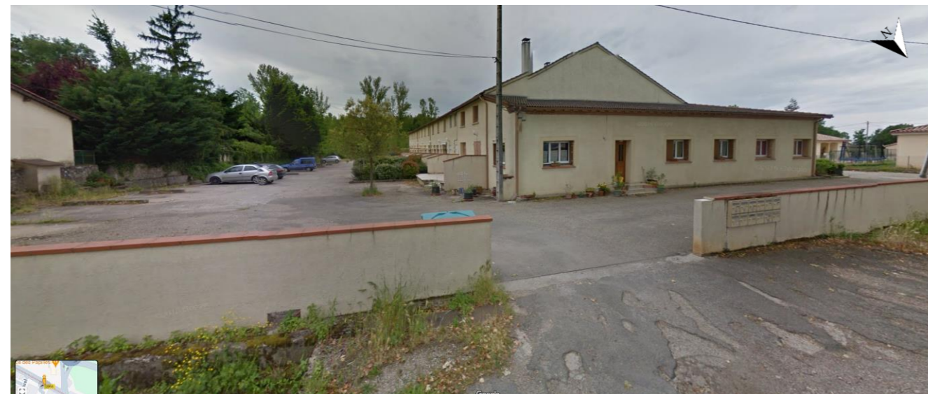
Photo 12 : Vue vers l'accès à la ZIP depuis la RD958 (source : Google Street View)
