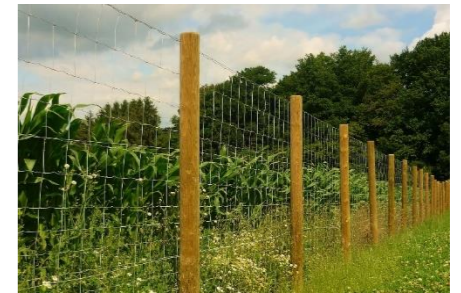
Exemple type de clôture avec poteaux en bois
