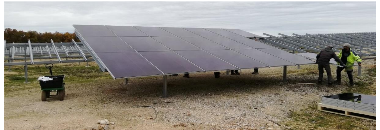
Photo 25 : Montage des panneaux sur le parc JPEE de Thenon (24) (source : JPEE)
