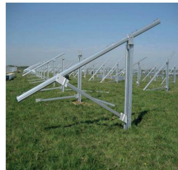
Figure 2 : Exemple de structures et fondations envisagées (source : JPÉE)
