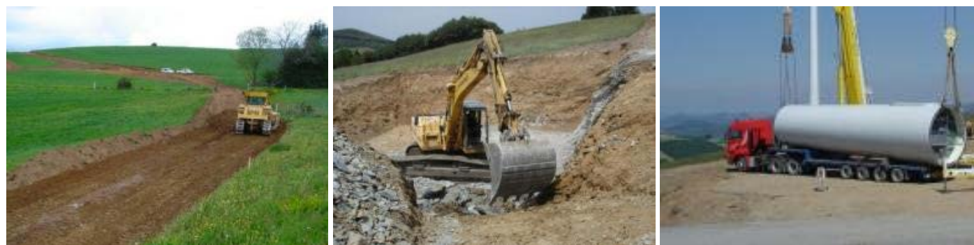
Photographie 106 : Illustration d'un chantier éolien.
