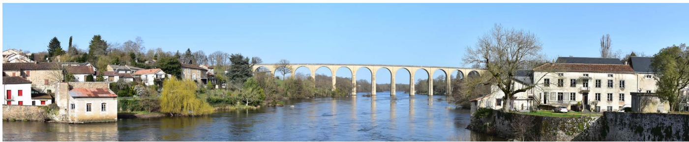
Photographie 2 : Pont sur la Vienne à l'Isle-Jourdain.
