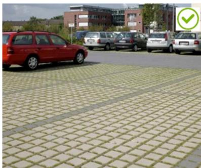
Pavés béton joints engazonné
