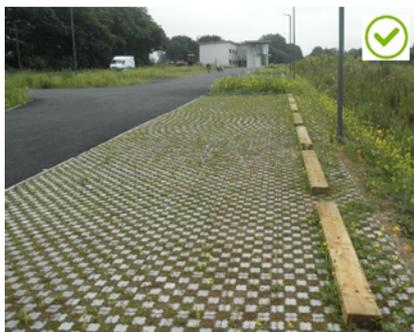
Dalle béton joints engazonné
