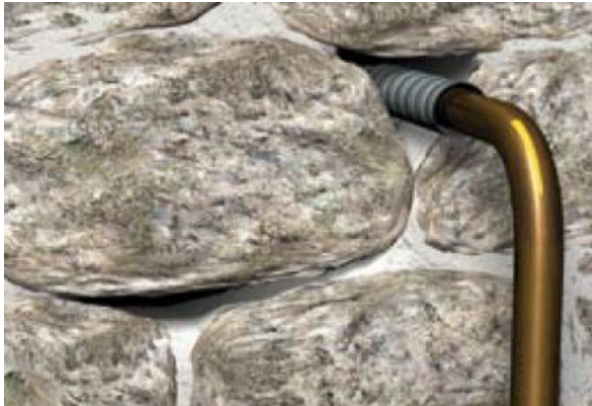
Situation initiale avant colmatage
