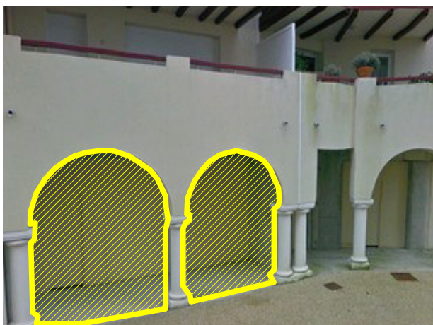
Obturation d'une travée de galerie
