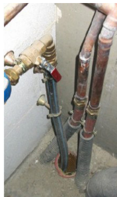
Exemple d'entrées de réseaux à calfeutrer
