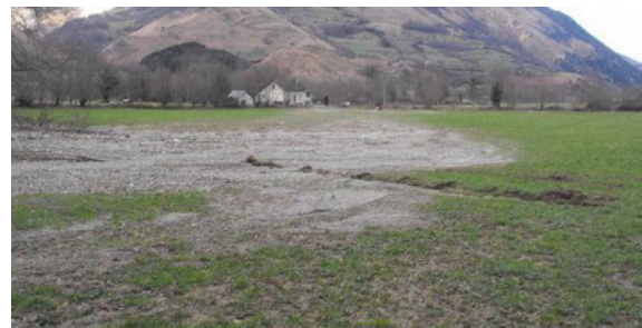
▲ ▶ Suberlaché, en aval de l'ancienne colonie de vacances 2014 [34]: épandage de boue et de pierres venant de la rupture de la digue du chenal (côté gauche de la photo droite), rejoignant l'ancienne route nationale (à l'arrière-plan).
