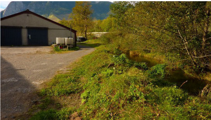
◄ Domaine de Carolle, 2014 [46] : vue de l'aval sur le léger endiguement en levée de terre le long du bras de décharge, dans la prolongation des digues. En arrière plan, la déviation et l'ouvrage de franchissement du remblai routier pour les écoulements en forte crue (Photographie AlpesGéoConseil).
