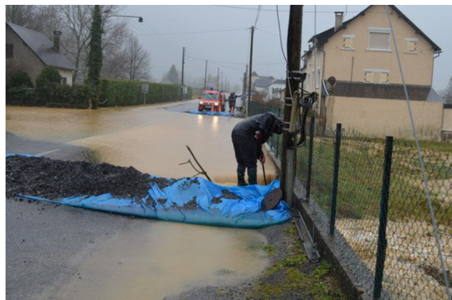
▲ Bas du quartier de Berthoumieu 25/01/2014 [32]: évacuation sur le pré en aval, déjà inondé par l'Aricq de Yes, et installation d'un bourrelet de matériaux pour éviter une propagation des eaux au-delà du carrefour de l'ancienne route nationale et de la rue de la Croix d'Orcun. (Photographie d'un riverain).
