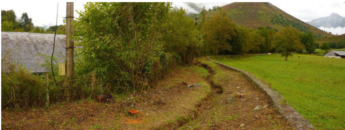
▲ Le chenal perché du Jouers au niveau de l'ancienne colonie, octobre 2014: vue de l'aval sur le chenal comblé d'anciennes alluvions anciennes, la très faible revanche de la digue, et le petit chenal qu'il a creusé naturellement en 2014. (Photographie AlpesGéoConseil).
